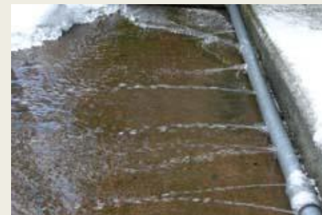
消雪パイプ設置（屋根・建物側面・前面・共有道路）
