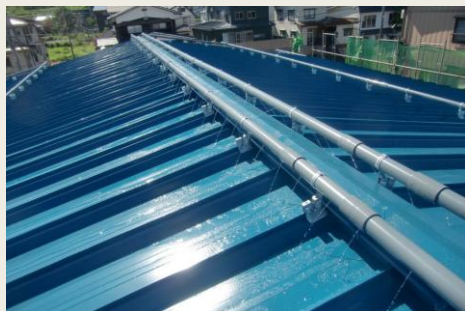
消雪パイプ設置（屋根・建物側面・前面・共有道路）
